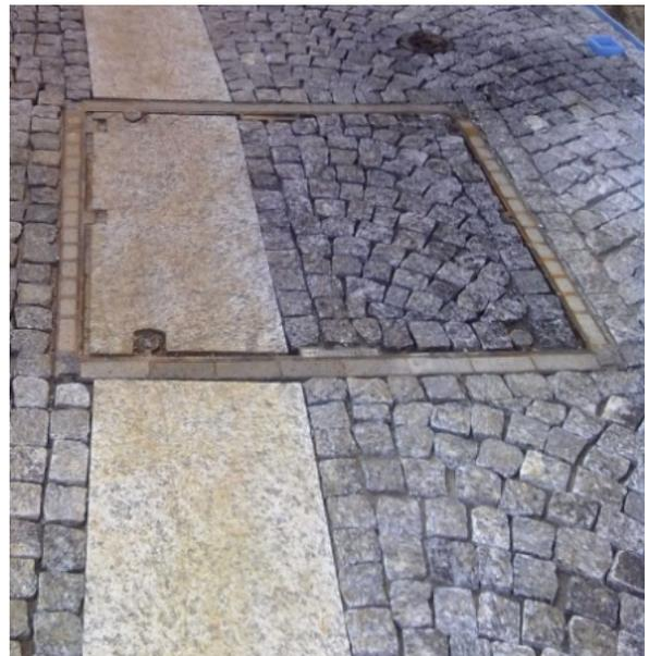
Con i responsabili delle AIL SA è già stato concordato che i coperchi, rispettivamente i chiusini in ghisa delle camere, necessari per la realizzazione della pavimentazione pregiata, verranno da loro forniti vuoti, per essere poi riempiti con la pavimentazione da parte dell'impresa di costruzione aggiudicataria dei lavori.
