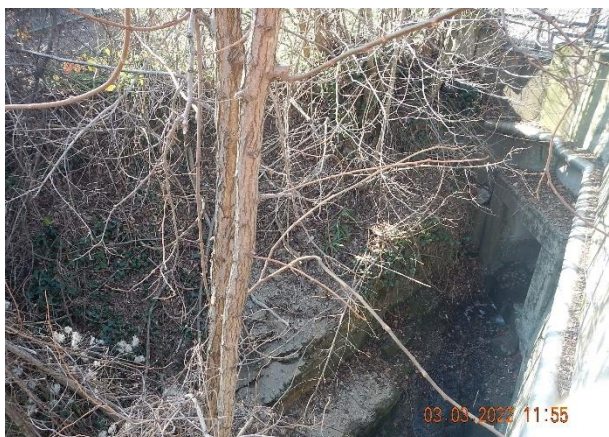
Figura 21 - Uscita riale Crena incanalato a valle di via Tersaggio
