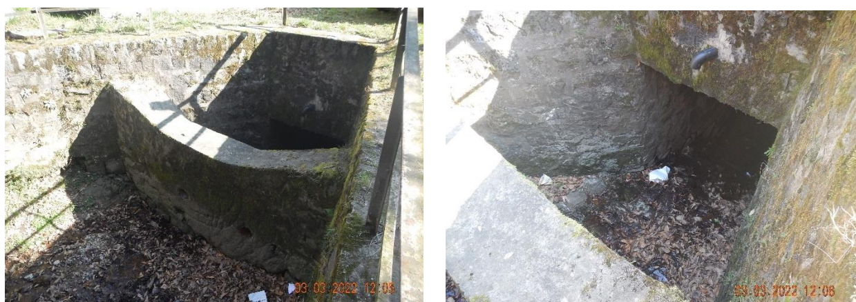
Figura 22 - Camera dalla quale il riale Crena diviene incanalato e prosegue su territorio di Canobbio
